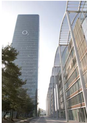
Zentrale mit Weitblick: Der Hauptsitz von Telefónica O 2 Germany im Hochhaus Uptown München
